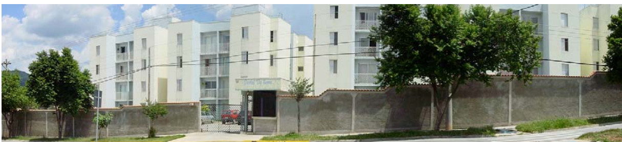
F.8 – Conjunto residencial Portal da Serra, na Av. Luis José Sereno
