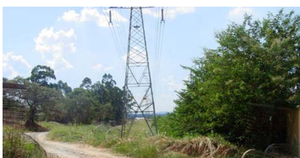
F.48 – Linha de Alta Tensão no limite do trecho sem asfalto da Av. Antonio Pincinato
