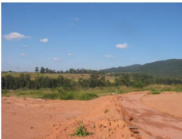
Figura 12, visada sul, interior do empreendimento com a Serra do Japi ao fundo
