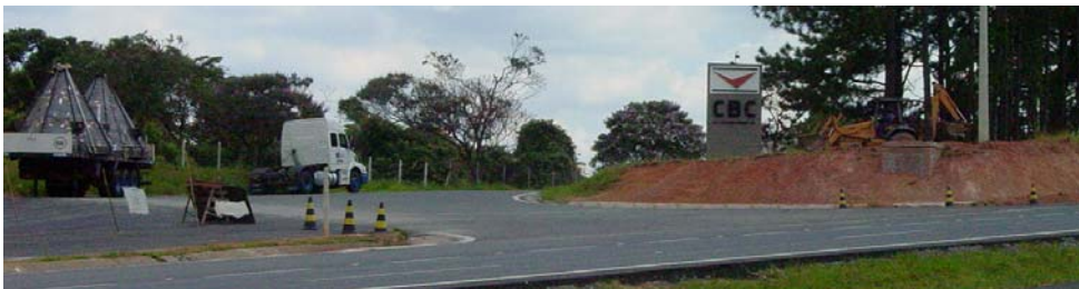
F.24 – Entrada da CBC junto à SP 300
