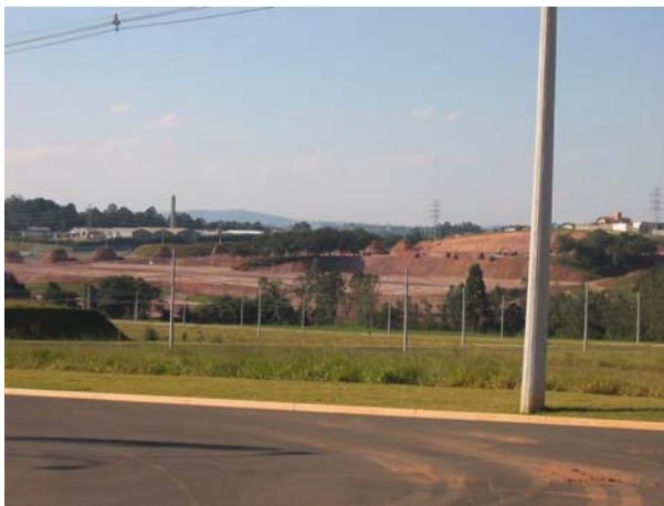
Figura 10, visada nordeste, indústrias presentes na região e empreendimento em fase de implantação.
