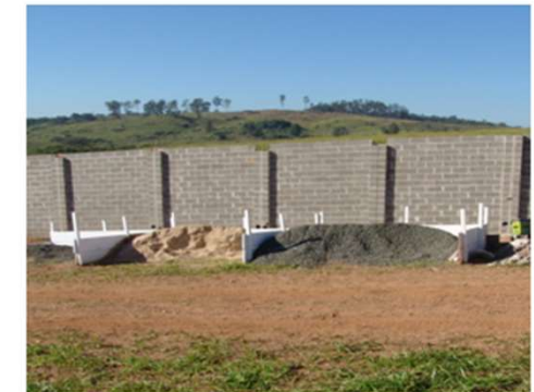
Baias itinerantes para deposição temporária de diferentes materiais da construção civil que estão sendo utilizados para a construção do muro.
