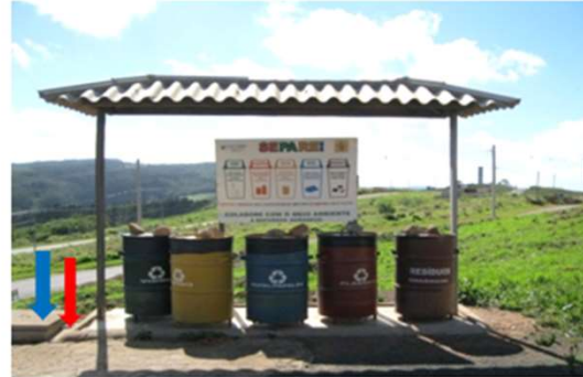
Vista de conjunto de tambores para coleta de resíduos. Seta vermelha indica canaleta de proteção no entorno e a seta azul a caixa para recebimento de chorume.
