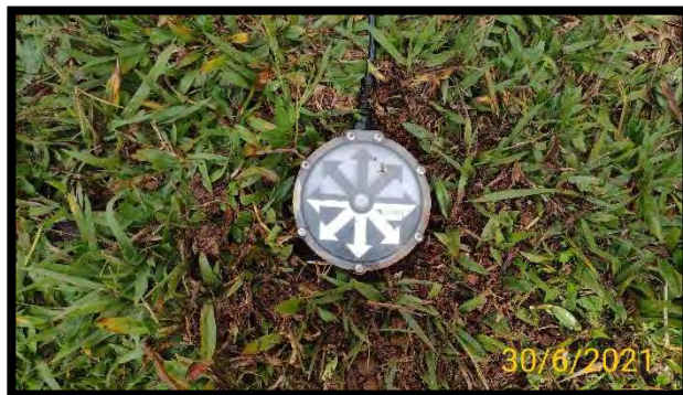
Fotos 3.3 – Instalação do Geofone
