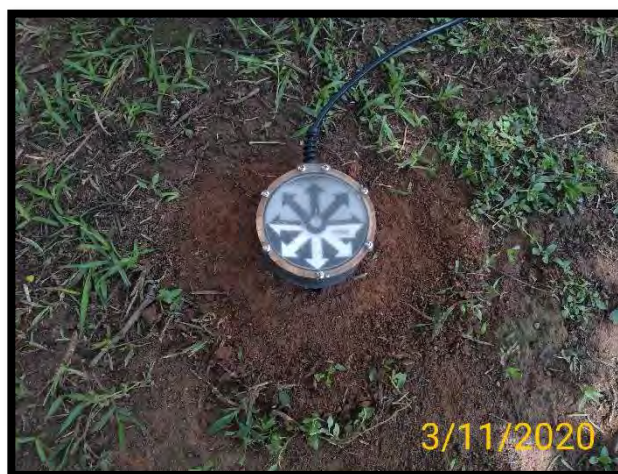
Fotos 3.3 – Instalação do Geofone
