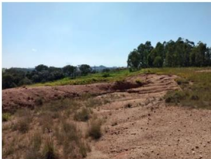
Foto 5.1.6.2-3 – Ponto 14 de campo, AID, onde pode-se observar erosão linear profunda induzida por obras de corte e aterro realizadas à montante, sem as devidas providências de estabilização posterior dos terrenos. Trecho médio a superior da vertente, com maiores declividades e vale em V encaixado
