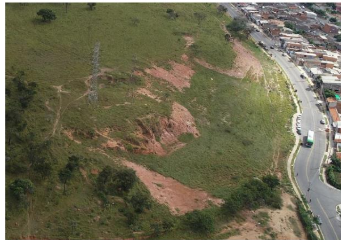
Foto 5.1.6.2-6 – Vista aérea do Ponto 09 do levantamento de campo evidenciando exposições de solo com início de processos erosivos na ADA do empreendimento
