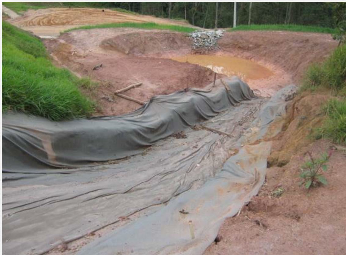
Descida d'água provisória e bacia de retenção de sedimentos
