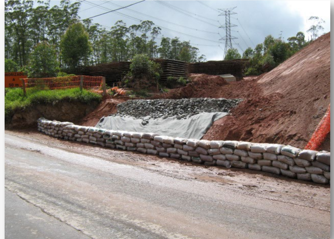
Segregação de áreas afetadas. Dispositivo de retenção de sedimentos formado por pedra rachão e linha de sacaria.
