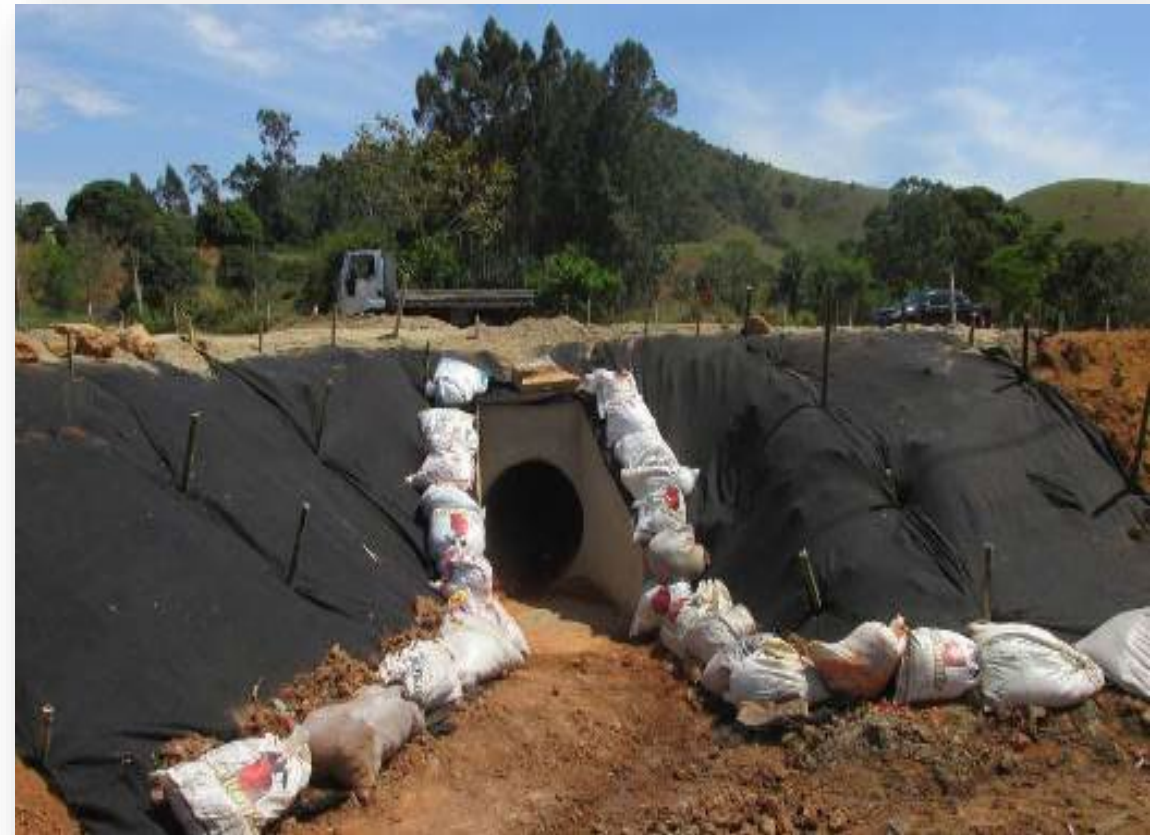
Proteção de taludes de aterro e cursos d'água.
