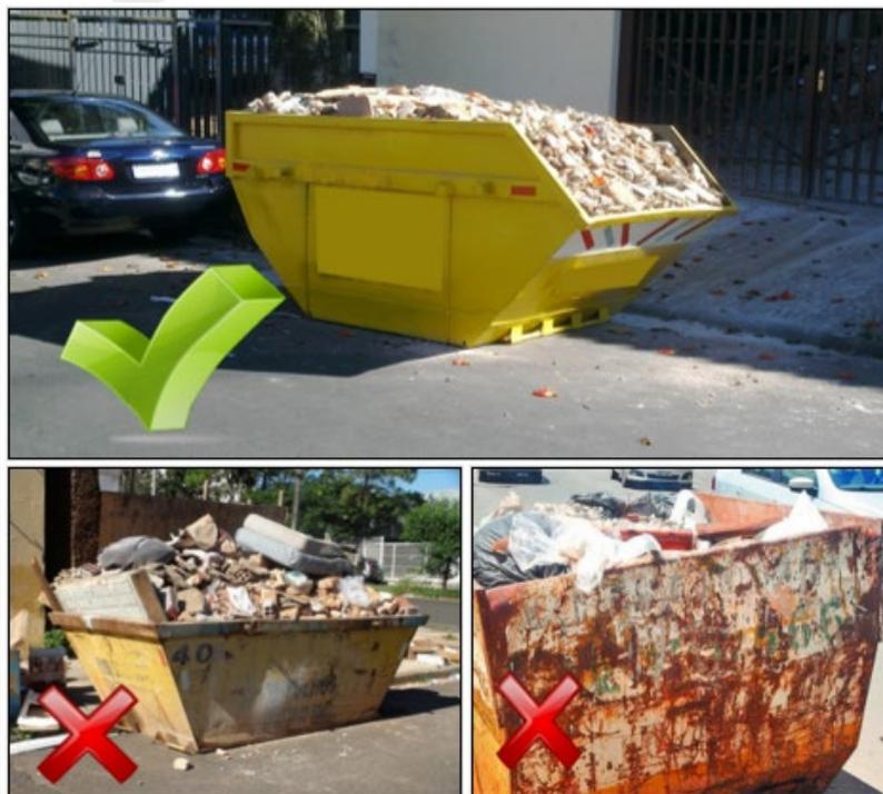
**Figura 185.** Modelo de acondicionamento de resíduos em caçambas.
