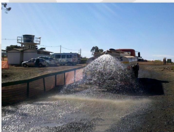
**Figura 180.** Exemplo de umidificação das vias da obra para evitar emissão de poeira e material particulado.
